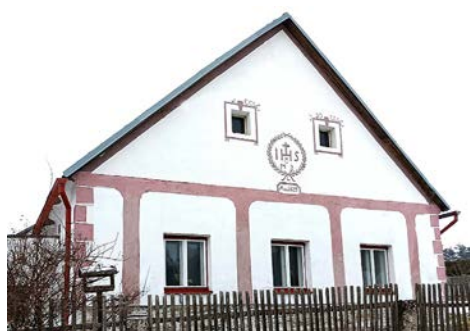
Obr. 4 Průčelí obytné budovy s výzdobou používanou zde v 1. pol. 19. století
