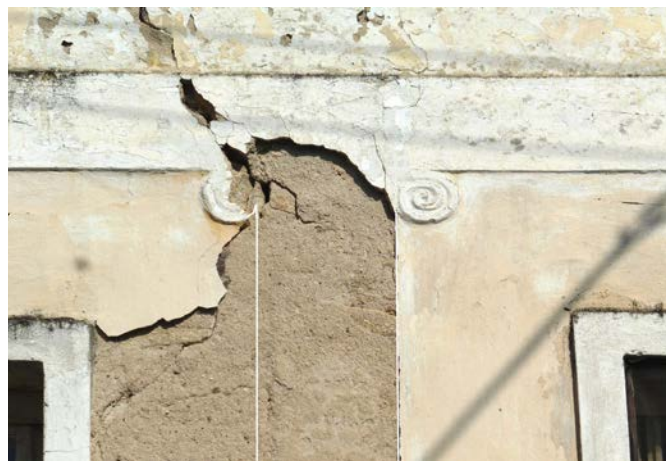
Obr. 8 Zbytky výzdoby z r. 1844 na průčelí domu čp. 10
