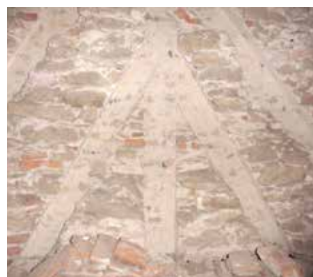
Obr. 6 Detail otisku krovu
