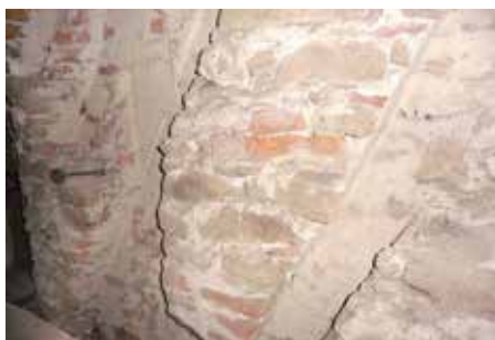
Obr. 7 Drážky ve zdivu věže
