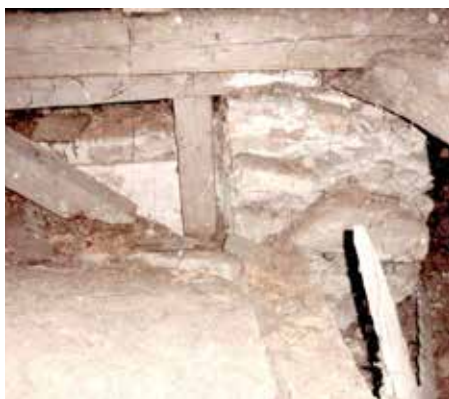
Obr. 4 Gotická zeď a stolice původního krovu
