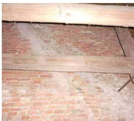
Obr. 5 Okraje gotického východního štítu lodi
